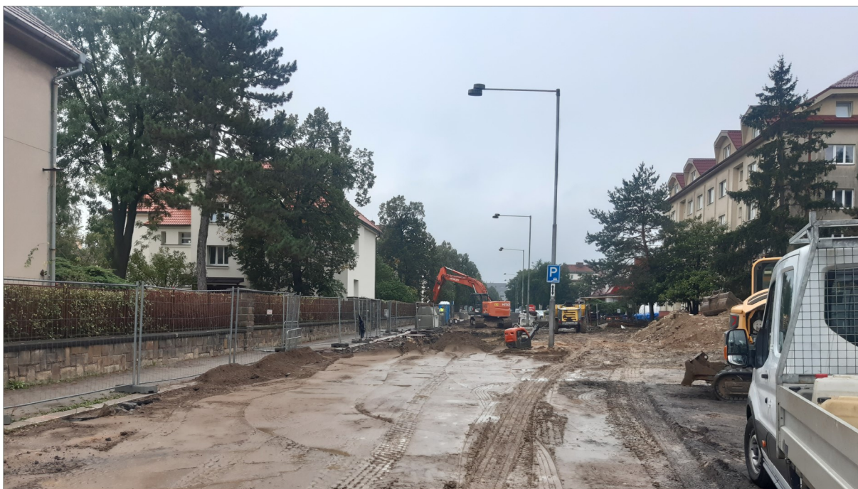
Obr. 1 Pohled na staveniště od severu.
