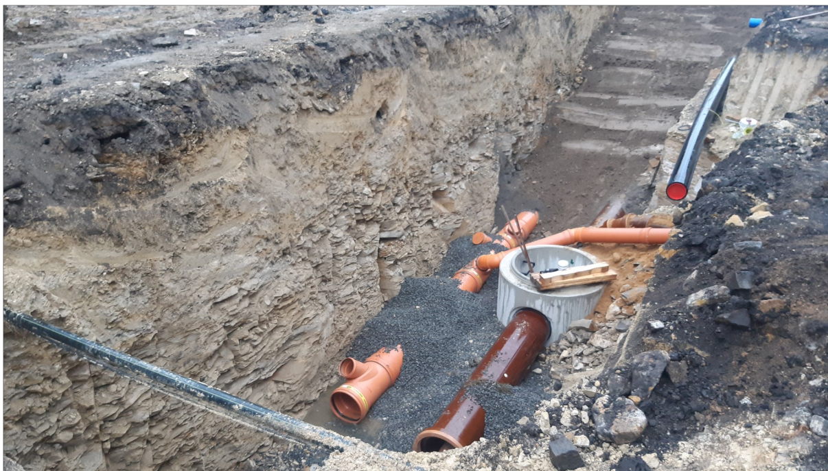
Obr. 2 Západní stěna rýhy.
